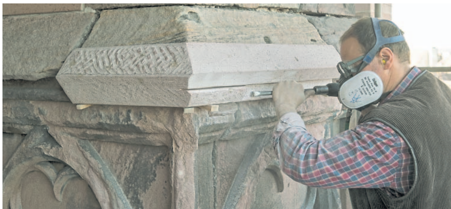
Handwerker bei Denkmalpflegearbeiten am Freiburger Münster.
