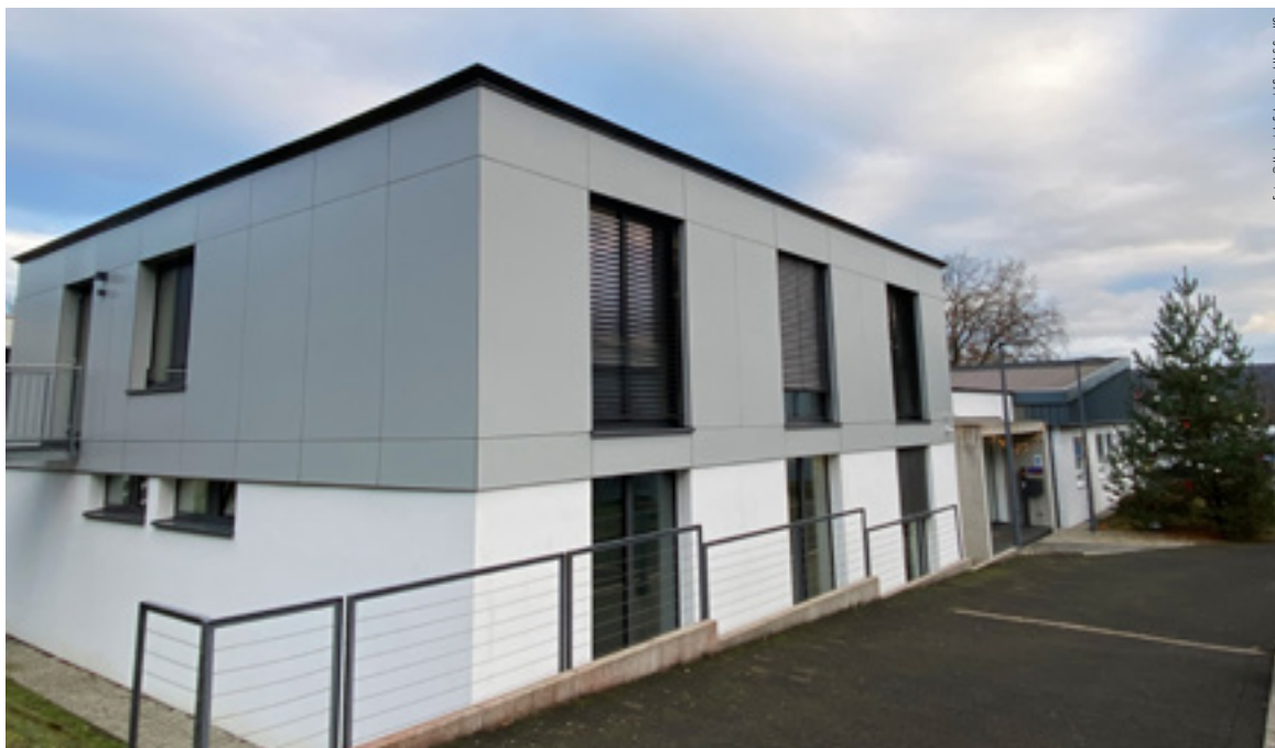
Blick auf Gebäude der Heinrich Schmid GmbH & Co. KG in Homburg, die seit 2009 EMAS-zertifiziert ist.
